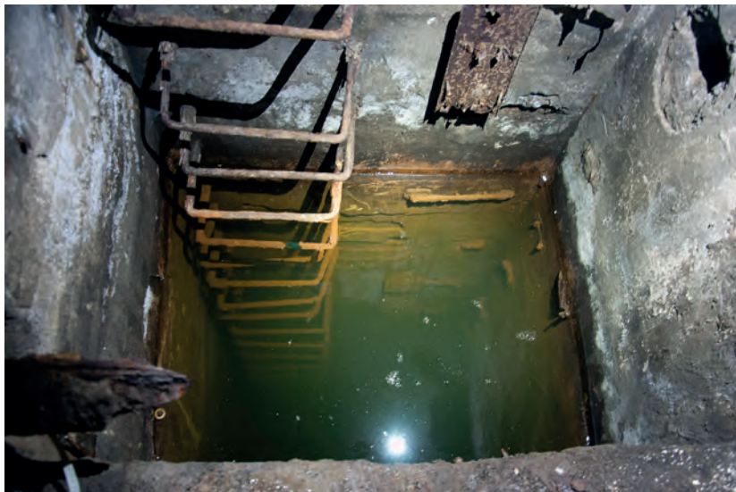
Фото 8. Вид на затопленный вертикальный спуск в потерну
