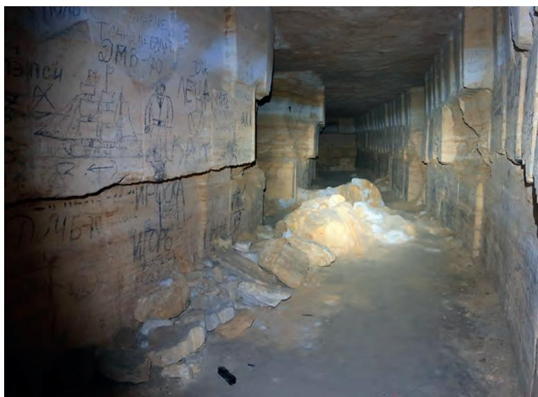
**Рис.3.** Выработка конца 1940-х годов, разрабатывавшаяся в 3 уступа.
