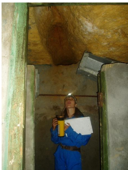
Фото 4. Вид на верхнюю часть пещеры кабинку санузла.
