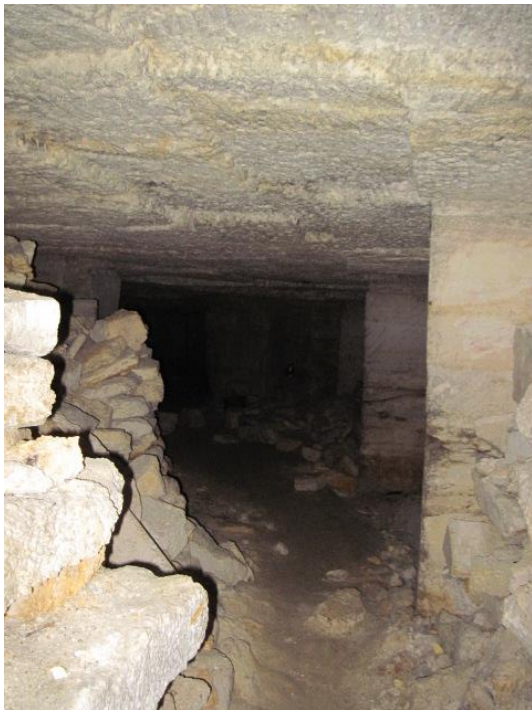
Фото 6. Классическая схема отделения каменных блоков. Следы на потолке.
