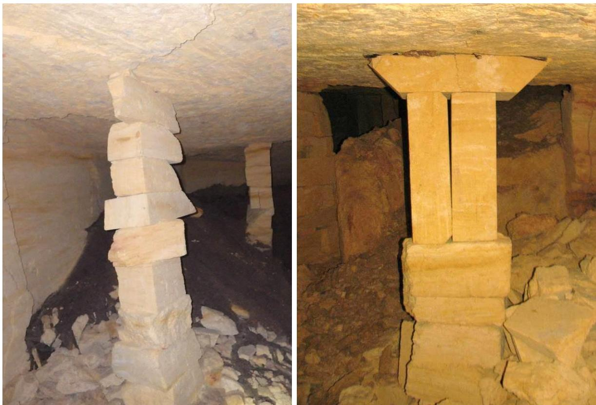
**Рис. 2. Крепление кровли колоннами из бракованных блоков известняка, сложенных «всухую»**
