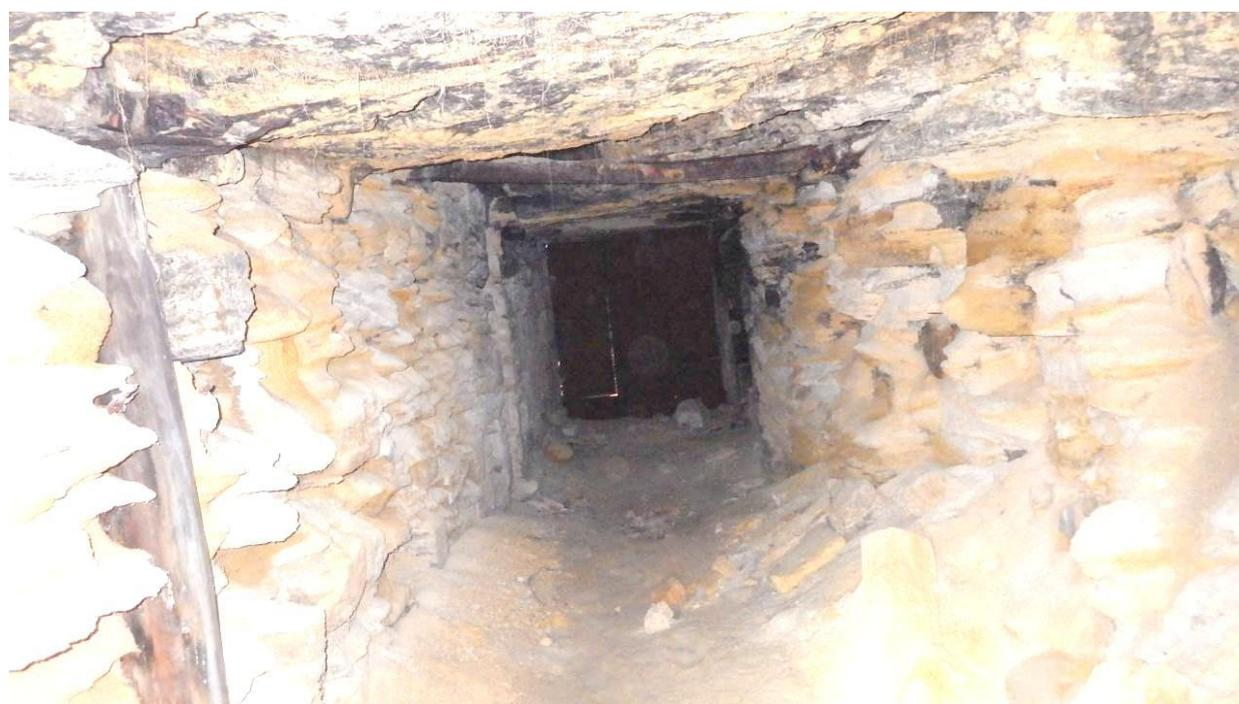
**Рис. 1. Крепление устья штольни металлической балкой, заведенной в пазы под кровлей выработки**
