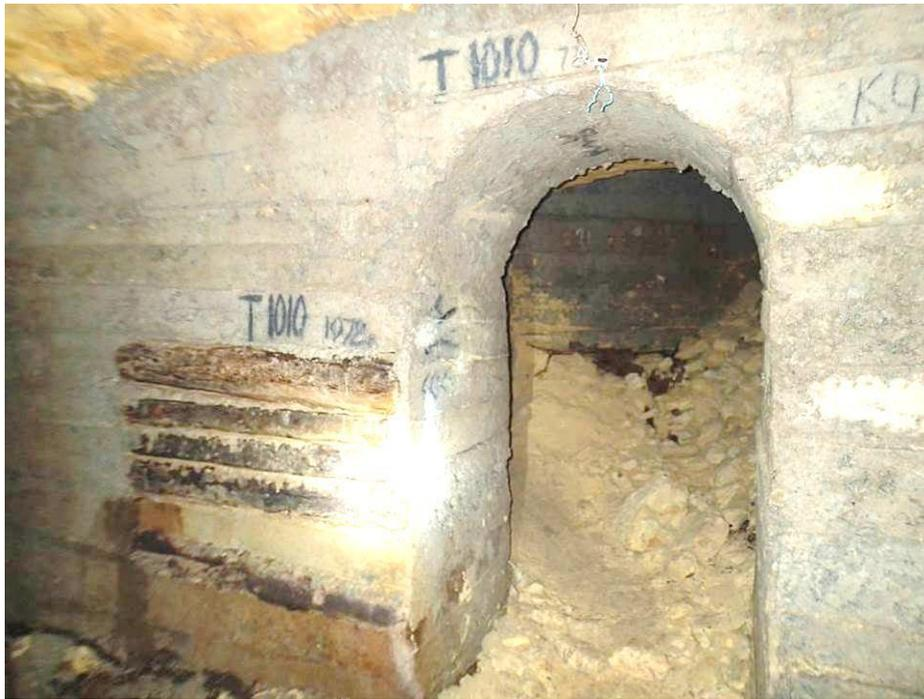
**Рис. 9. Поперечная бетонная перегородка с арочным проёмом- «диафрагма»**
