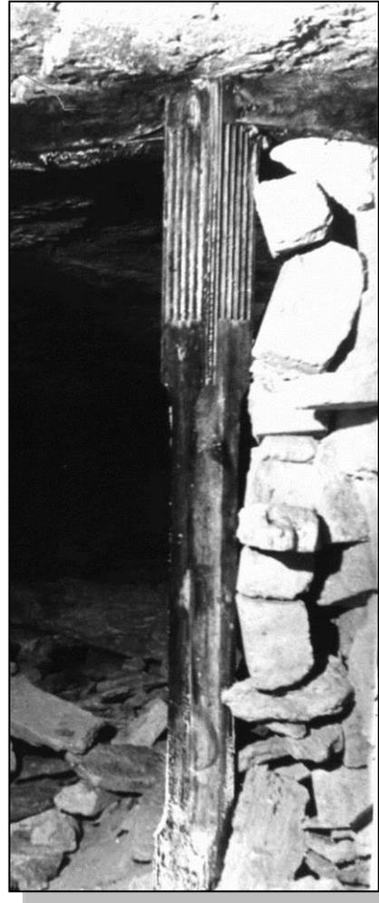
**Рис. 3. Крепление кровли деревянной стойкой (используется подручный вторичный материал – деревянная деталь от мебели)**
