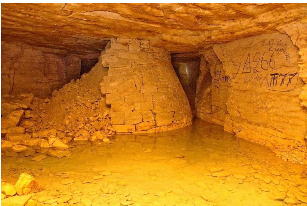
**Рис. 6. Конусовидные подпорные колонны – «груши». Внешняя часть сделана из блоков известняка, внутреннее пространство заполнено штыбом**
